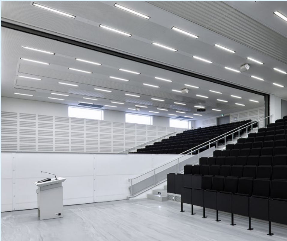
Mobile Trennwand - hier zu einem Drittel hochgefahren
