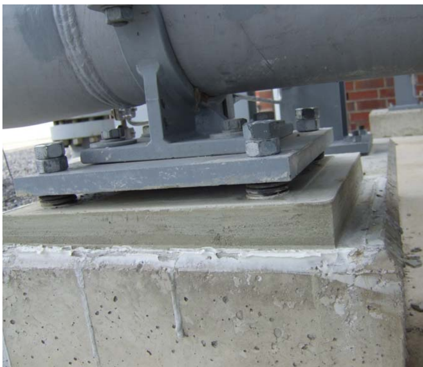
Abbildung 6: Rohrleitungshalter mit Tellerfedern.
