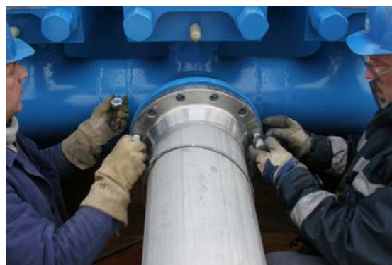
Bild 9: Druckleitungsmontage an Pumpe
