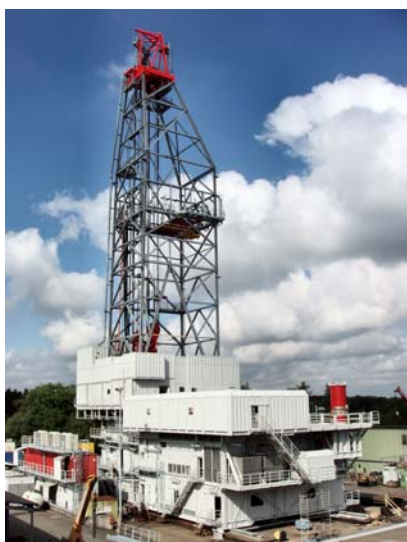
Bild 10: Bohranlage vor Abnahme im Mai 2005
