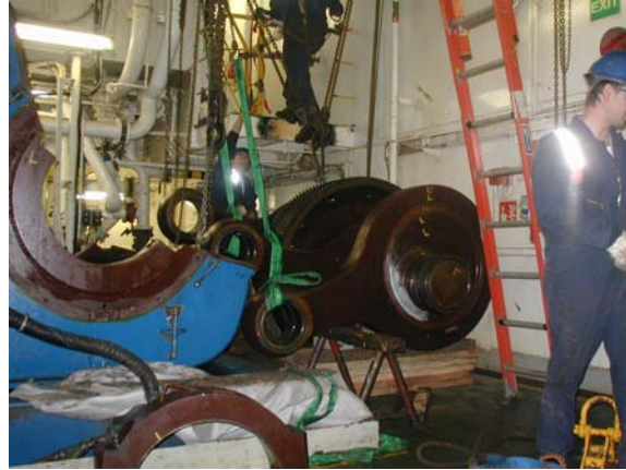
Bild 13: Pumpenreparatur
