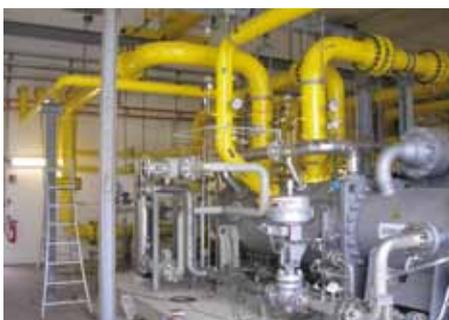
▲ Abbildung: Magnetgelagerte Turboverdichteranlage mit angeschlossenen Rohrleitungssystem
