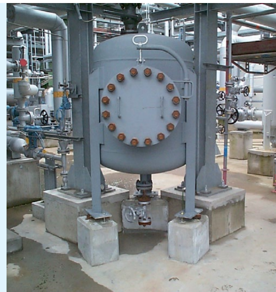
Abb. 2: Installierter Helmholtz-Resonator zur Reduktion des pulsationsbedingten Messfehlers.
