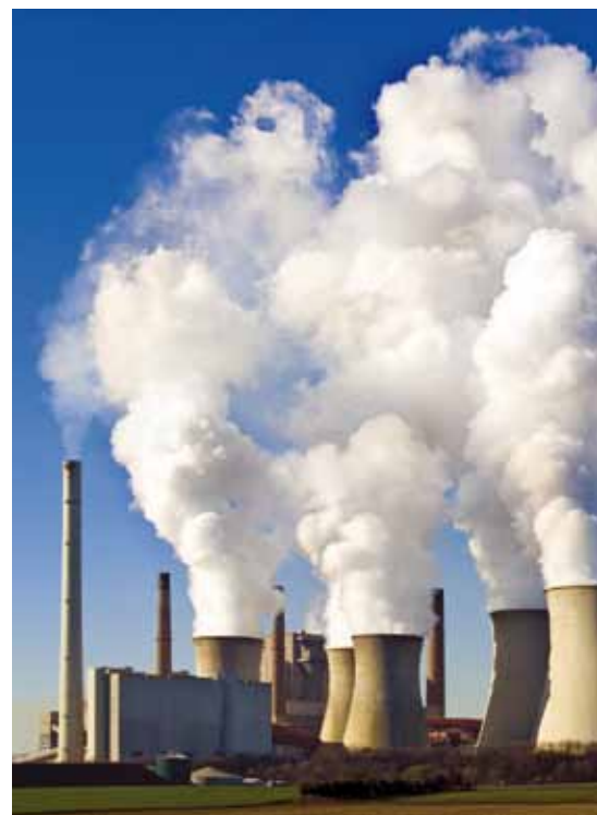
▲ Informieren Sie sich über Schwingungen im Kraftwerk
