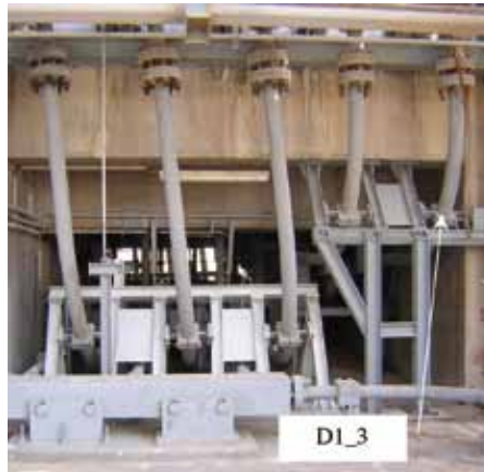
▲ Abb. 1.6: Messpunkt D1_3 mit Modifikation der Abstützung.
