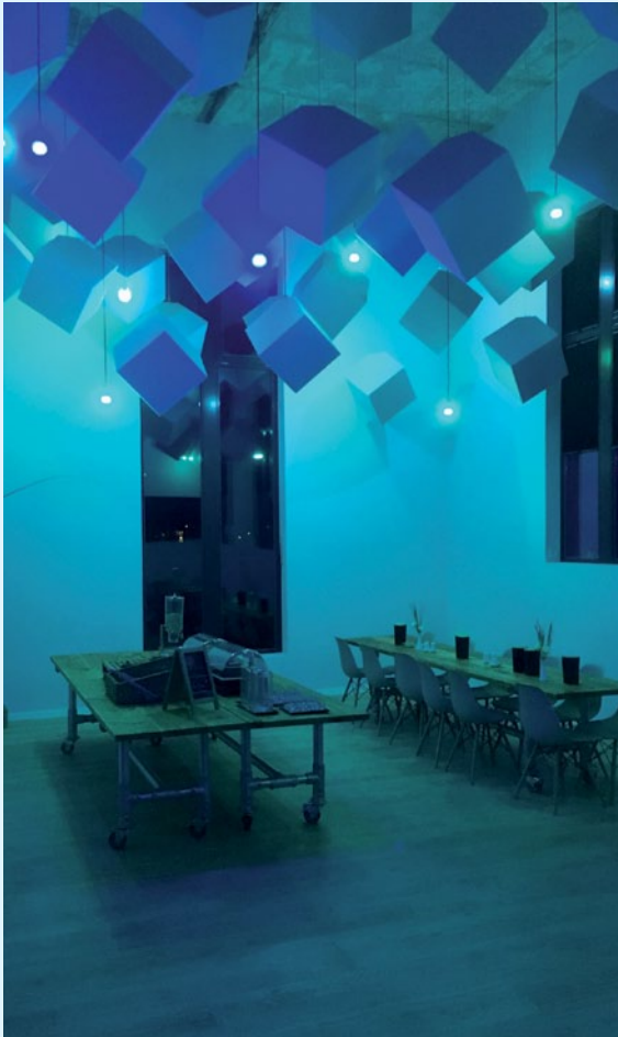
Realisierte Akustik-Kuben mit Beleuchtung
