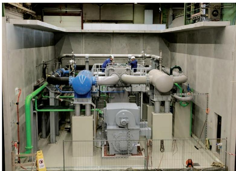
Abb. 6: Verdichter M15 kurz vor der Inbetriebnahme
