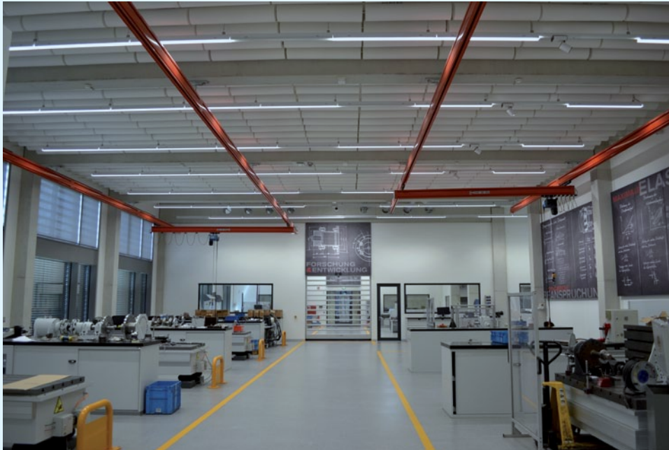
F&E-Zentrum nach dem Einbau der Absorber
