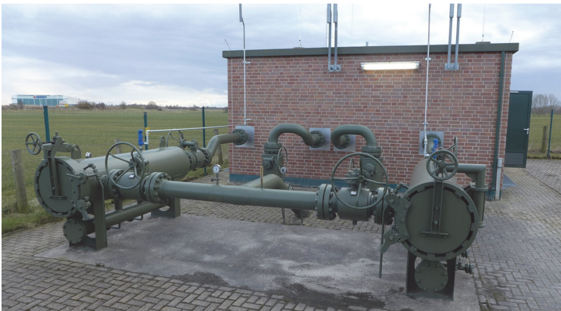
Abbildung 1: Gasübernahmestation
