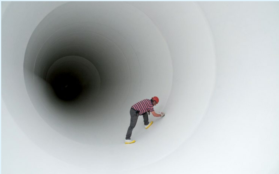
Druckrohrleitung der M11 nach Fertigstellung der Oberflächenbeschichtung
