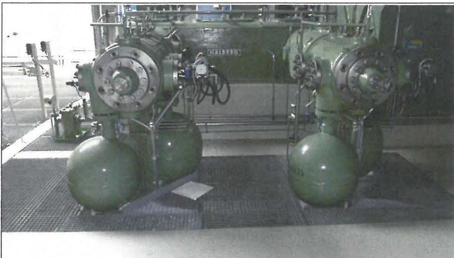
**Abb. 3 Kolbenverdichter K-201 im Originalzustand mit kugelförmigen Pulsationsdämpfern**
