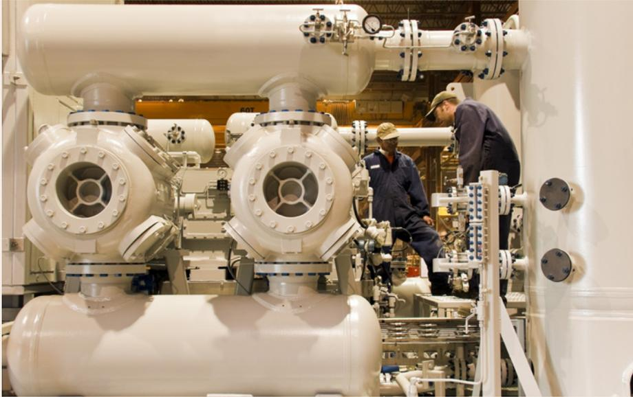
**Bild 3:** Typische Kolbenverdichterinstallation in 4-Zylinder Boxeranordnung mit saug- und druckseitigen Pulsationsdämpfern zur Erdgasverdichtung
