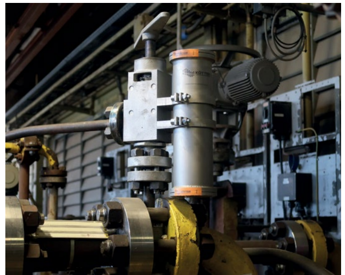
Abb. 2: Exemplarische Installation des Schwingungstilgers MAGIC TUBE XS an einem Ventilkörper
