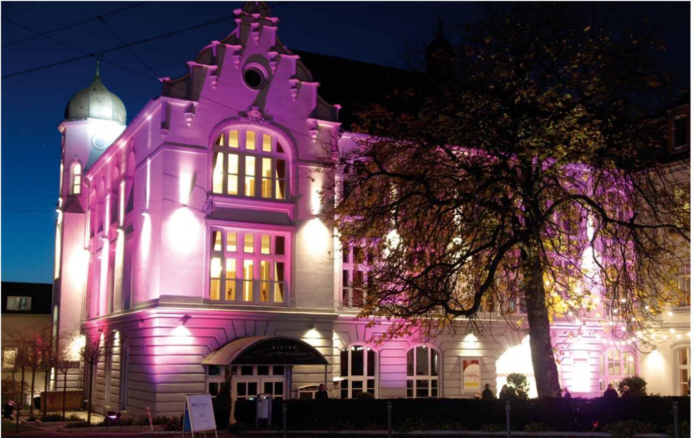
Schauburg, Iserlohn (2008) Auftraggeber / Architekt: Hellweg-Immobilien GmbH / Ingenieurbüro Hilker Ingenieure und Architekten
