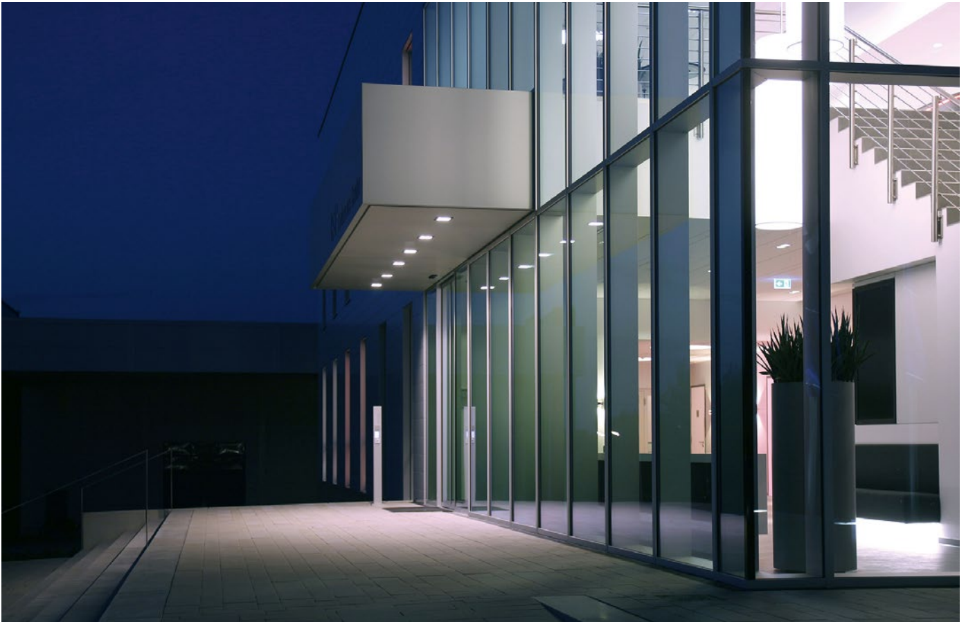
ISP Conference Center, Salzburg (2015) Bausumme: ca. 3,5 Mio. EUR Auftraggeber / Architekt: ISP Salzburg / Schnoklake Betz Architekten BDA (Münster)
