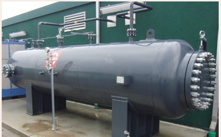
Bild 5: Pufferbehälter ( V = 5 \text{ m}^3 ) zur Überbrückung beim Regenerationsbetrieb
