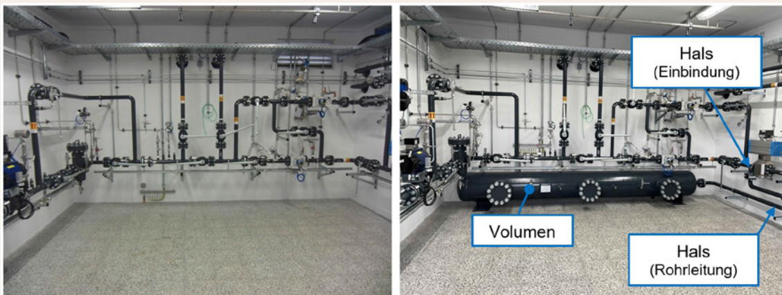
Bild 14: Originalsituation (links) und nach Umsetzung der Minderungsmaßnahme Helmholtz-Resonator (rechts)
